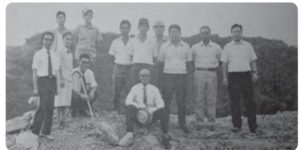
エデンの園建設着工当時(昭和52年)
